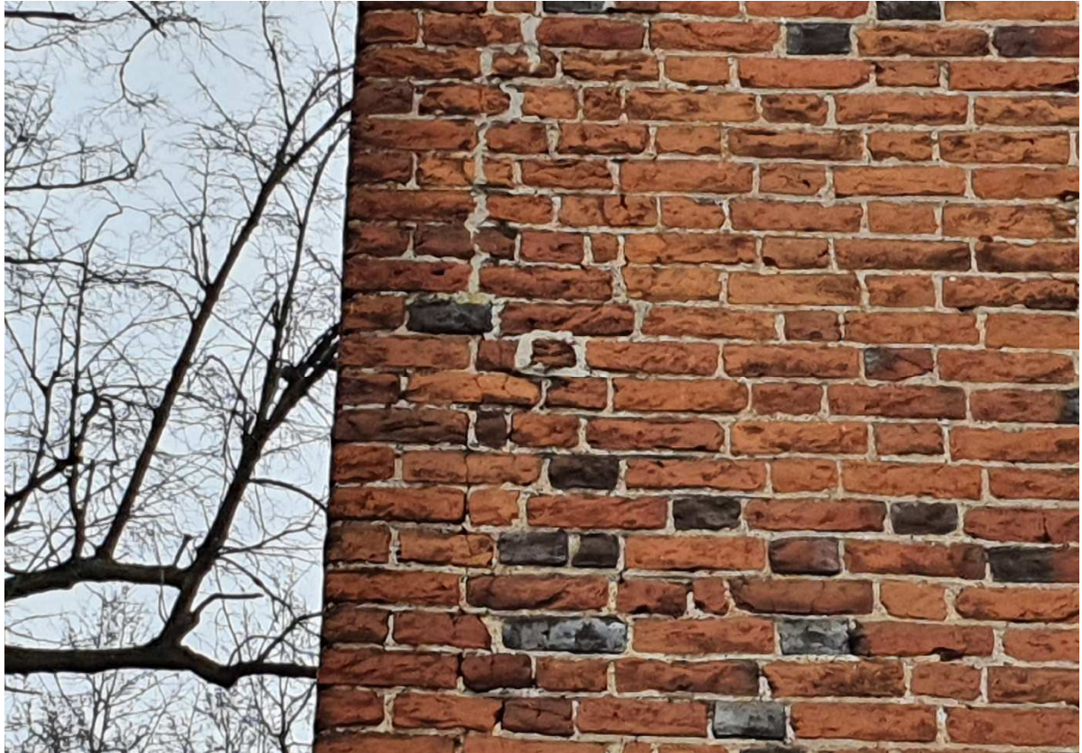
Fot.5. Grodziczno, kościół pw. św. Piotra i Pawła. Południowo-zachodnie zwęglowanie elewacji. Na zdjęciu widoczne pionowe, częściowo zamaskowane spękanie wątku.
