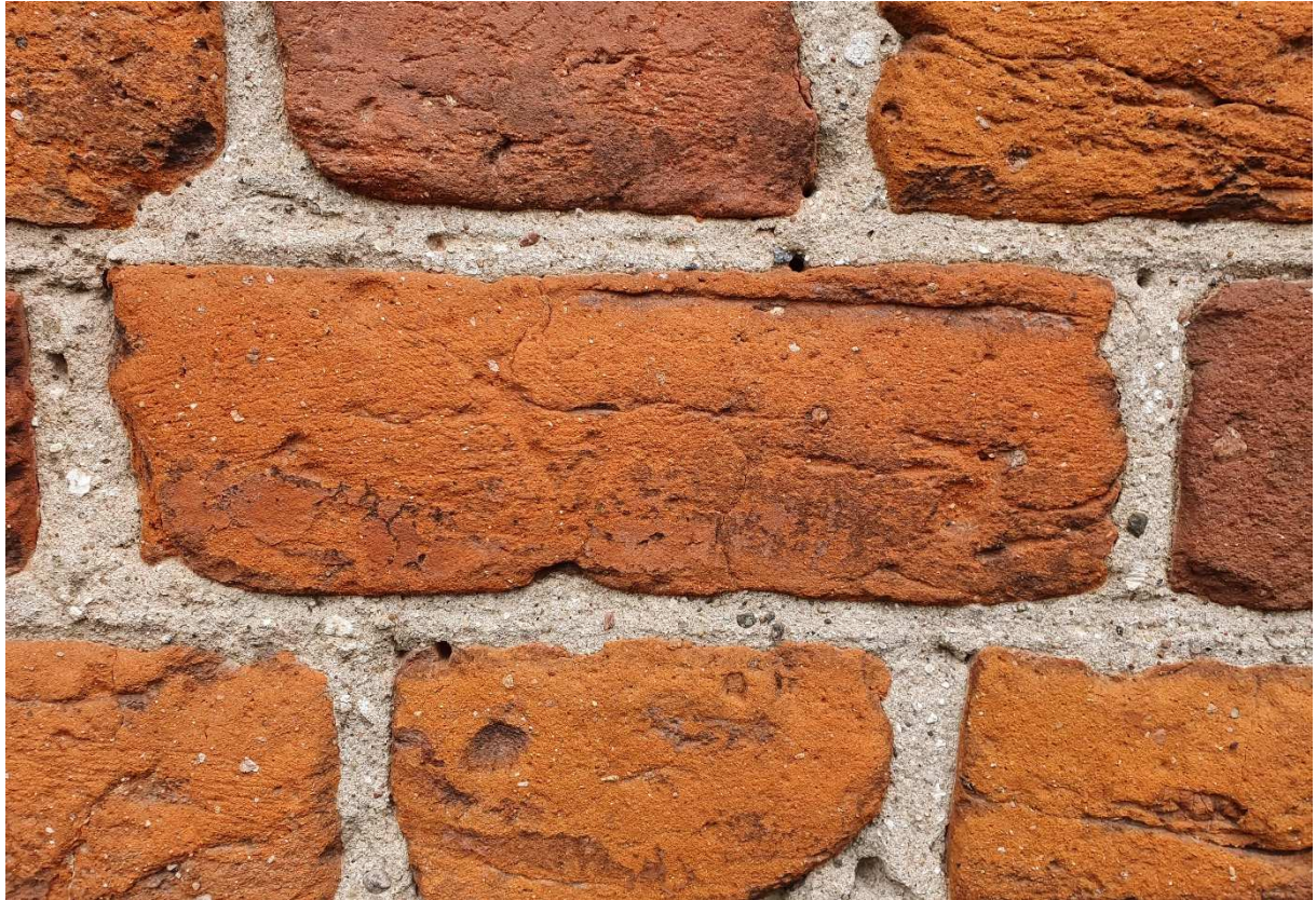
Fot.15. Grodziczno, kościół pw. św. Piotra i Pawła, fragment wątku ceglanego z XIX-wieczną spoiną cementowo-wapienną.
