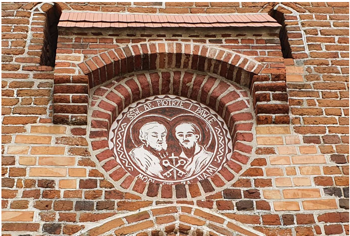
Fot.18. Grodziczno, kościół pw. św. Piotra i Pawła, kruchta zachodnia. Równocześnie z dekoracją szczytu wschodniego powstał portret patronów kościoła nad głównym wejściem. Dekoracja wydaje się być wykonana w technice tradycyjnego sgraffita.
