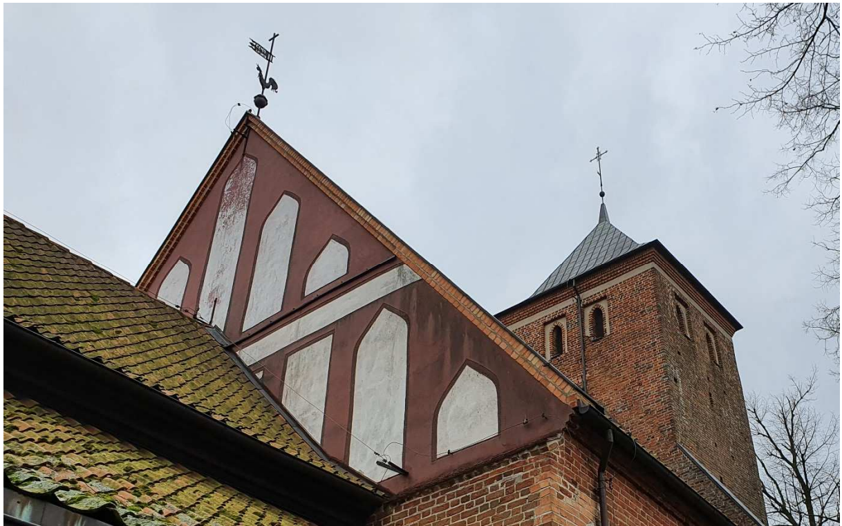
Fot.17. Grodziczno, kościół pw. św. Piotra i Pawła, szczyt elewacji wschodniej korpusu. Na zdjęciu widoczny dekorowany tynk pochodzący z remontu przeprowadzonego w latach 1994-2001. Dekorację wykonano w technice mieszanej, łączącej cechy sgraffita i polichromii.
