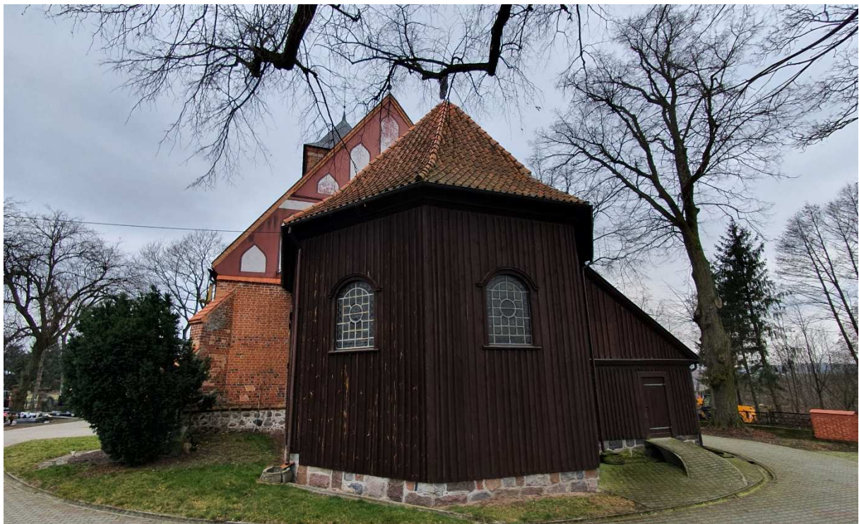
Fot.4. Grodziczno, kościół pw. św. Piotra i Pawła. Widok ogólny od strony wschodniej.
